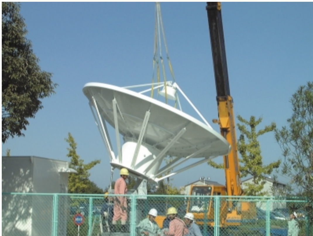
直径4.5mのアンテナが設置された。
