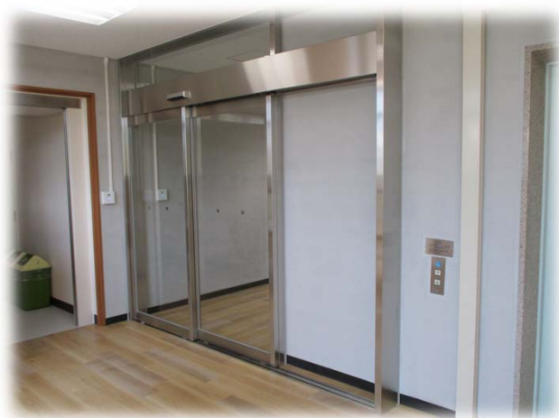
【2階 自動扉の設置】
