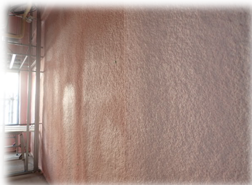
【外壁面への断熱材吹付】
