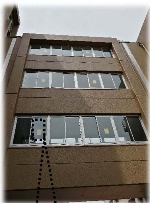
【渡り廊下 外観】
