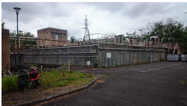
排水処理施設外観
