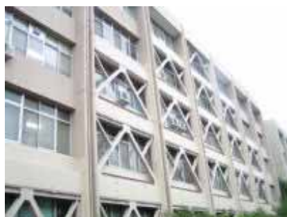
耐震補強後の臨床研究棟
