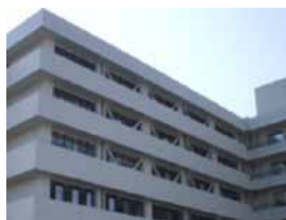
改修後のC病棟
